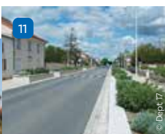
Canton de Saint-Jean-d'Angély Aménagement de la traversée de Villeneuve-La-Comtesse
