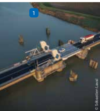
Canton de Marans Pont du Brault
