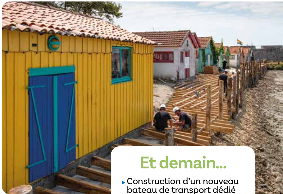
Travaux d'appontement au Château-d'Oléron
