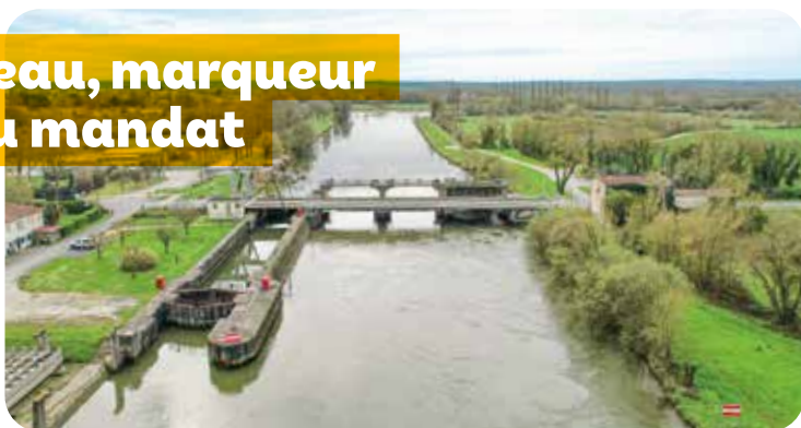
Barrage de Saint-Savinien
