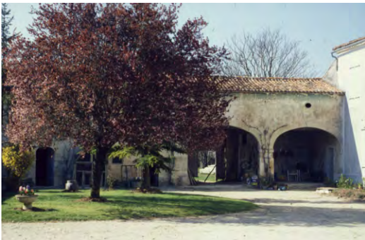
Dépendance refermant la cour de la maison
