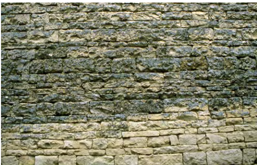
Moellons assisés (de carrière)
